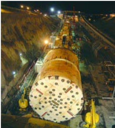
Montaje de Tuneladora.
